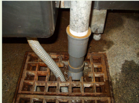
② シンクの排水管から排水溝までパイプをつなぐ
