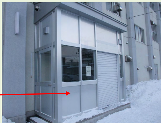
隔壁及び扉を設置した検収室
